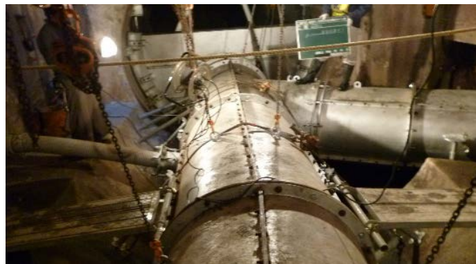
【説明16】下流側分解搬入型ハーフプラグ、導管 Φ3500用ハーフプラグ、Φ1200mm導管設置完了
