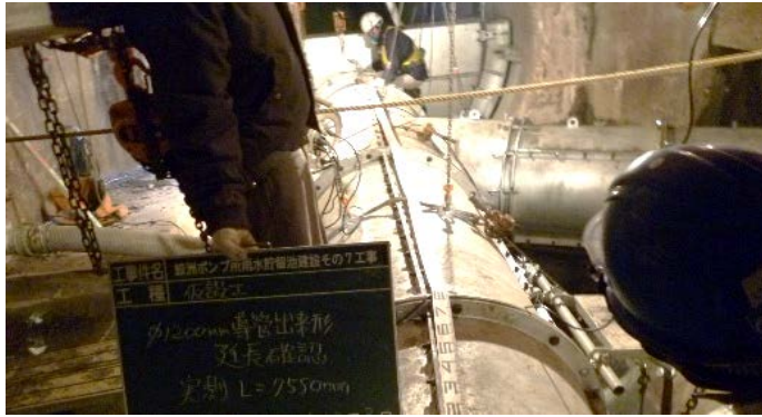
【説明14】分解搬入型 Φ1200mm導管 下流側導管接続作業
