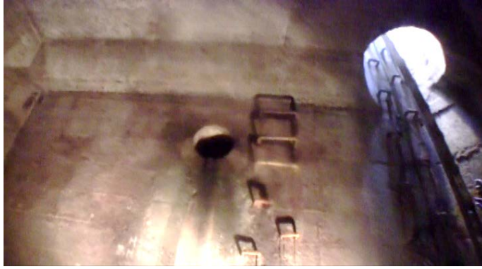
【説明5】既設人口内 w5500×w5500×h4640 今回改修する既設人孔内部を見る
