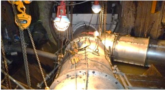
【説明13】分解型ハーフプラグ Φ3500用 下流側プラグへ分解搬入型 Φ1200mm導管接続状況
