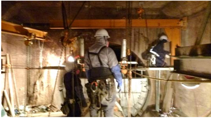
【説明10】分解型ハーフプラグ Φ3500用 既設管 Φ3500mm上流側ハーフプラグ組立状況
