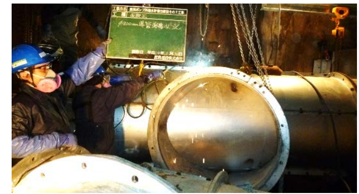
【説明9】分解搬入型 \Phi 1200mm 導管 \Phi 1200mm 導管の組立完了状況
