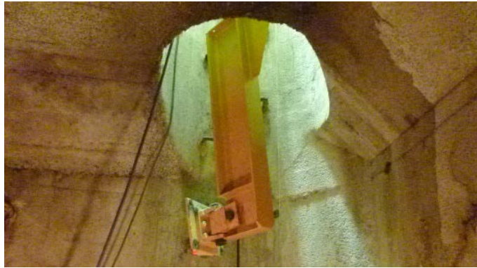
【説明4】既設人口内 w5500×w5500×h4640 搬入開口部から機材搬入状況
