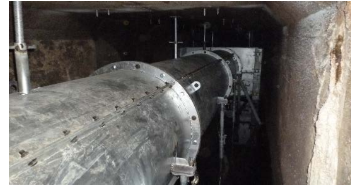
【説明18】分解搬入型 Φ1000mm導管 奥に見えるのが分解型Boxプラグ H2250×W2025
