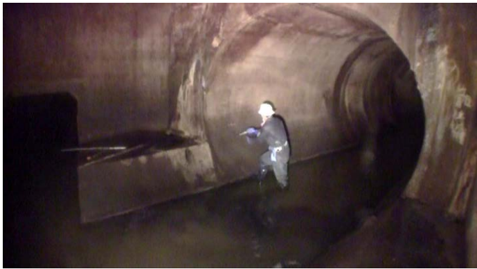
【説明1】鮫洲幹線 \Phi 3500mm 壁面シュミットハンマー強度確認
