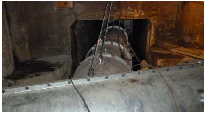
【説明17】分解搬入型 Φ1000mm導管 主要幹線部 Φ1000mm導管 Φ1200mm導管へ接続
