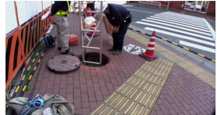
【説明3】マンホール開口 \Phi 900mm 機資材搬入はここからとなる
