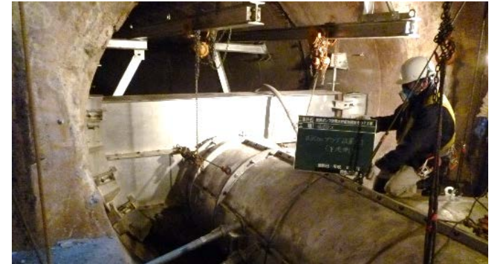
【説明12】分解型ハーフプラグ Φ3500用 上流側プラグへ分解搬入型 Φ1200mm導管接続状況
