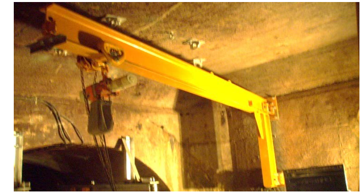
【説明6】既設人口内 w5500×w5500×h4640 既設人口内へ1Tonジブクレーン2台設置
