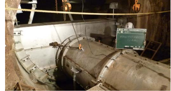
【説明15】上流側分解搬入型ハーフプラグ、導管 Φ3500用ハーフプラグ、Φ1200mm導管設置完了
