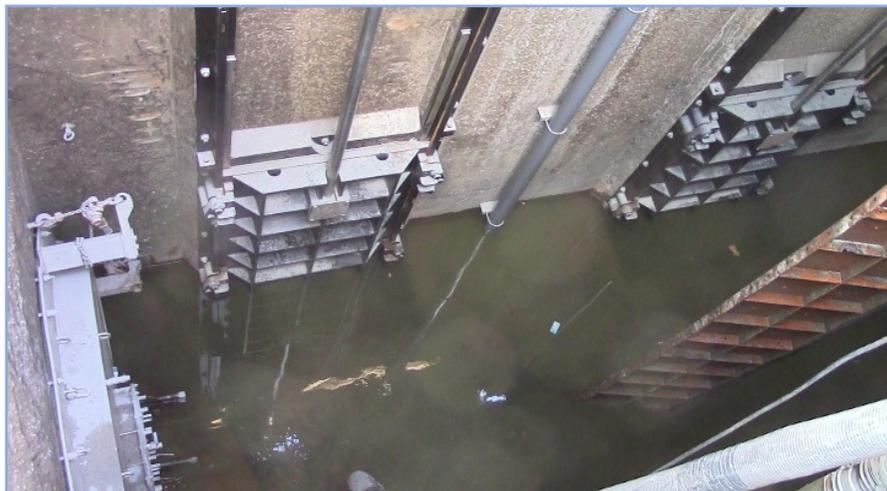
【流入ゲート改修完了写真左が設置プラグ】
